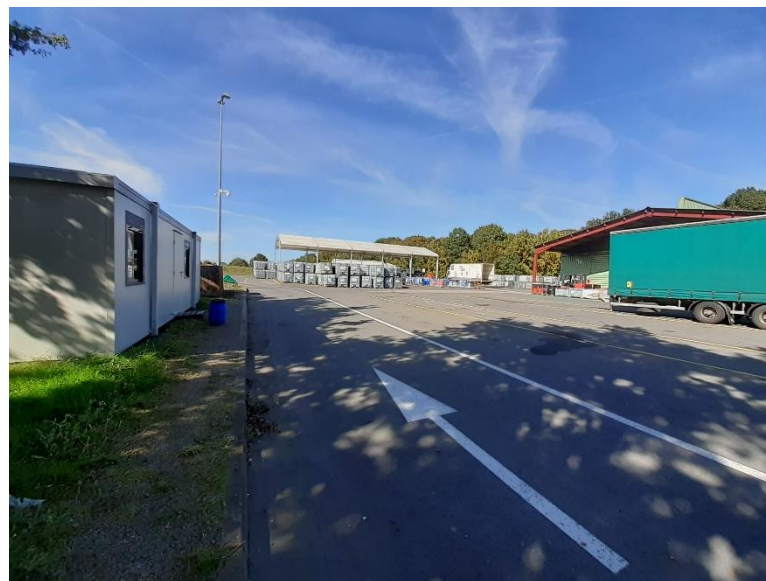
Photo 2 : Vue sur la zone de réception D3
