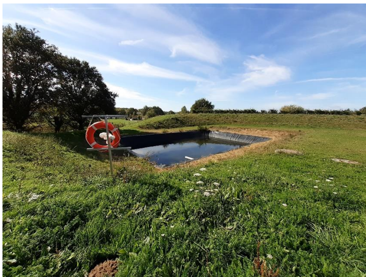
Photo 3 : Vue sur un des bassins de rétention
