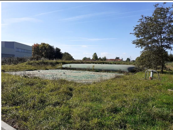
Photo 19 : Réservoirs mobiles perméats
